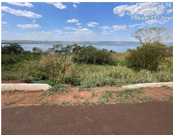
e. Exutório superficial na avenida Treze (entre as ruas Quatro e Dois)
