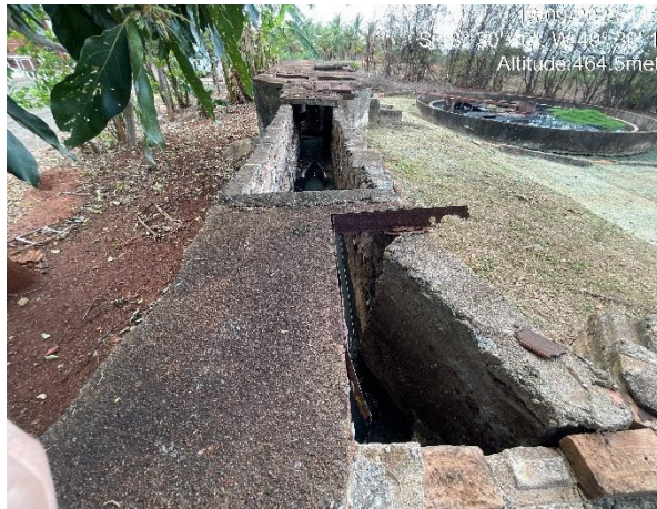
Entrada da ETE, estrutura projetada com gradeamento, calha Parshall e caixa de área
