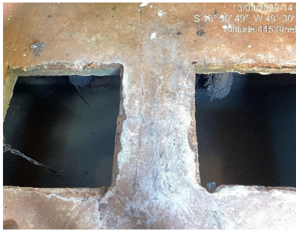
d. Poço de sucção da EEB-2
