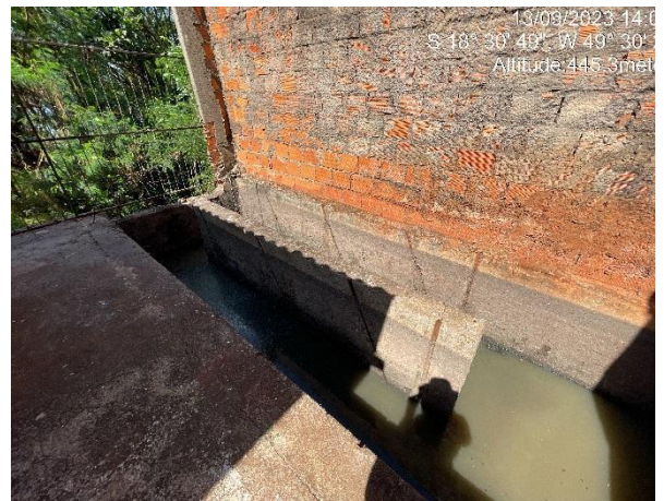
c. Desarenador da EEB-2
