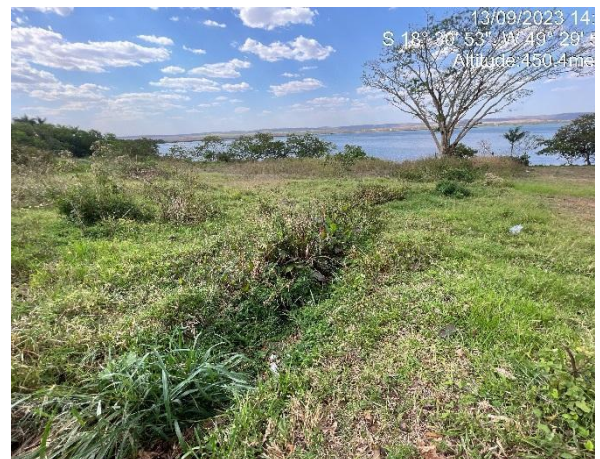
f. Canal em solo após exutório subterrâneo da água pluvial coletada nas bocas-de-lobo dos cruzamentos da rua Dois com avenida Cinco, BR-154, avenida Um e avenida Treze
