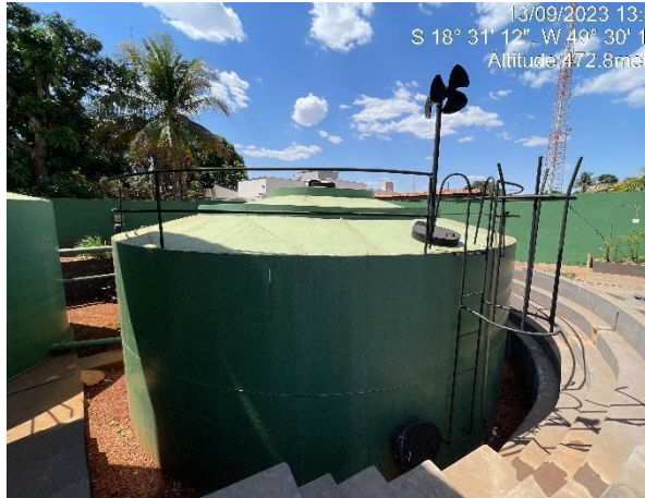
Reservatório semienterrado de 150 m 3 (poço de sucção da EAT)
