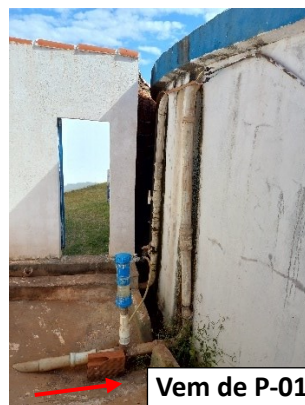
Figura 35. Poços tubulares profundos em operação na área urbana de Ipiaçu.
