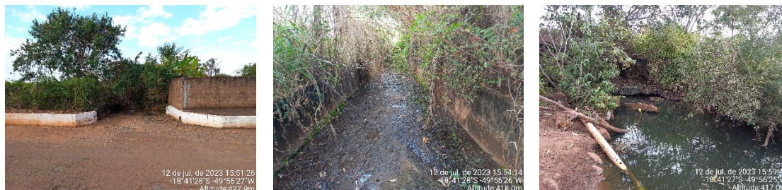
Figura 77. Registro fotográfico dos exutórios de águas pluviais existente na área urbana de Ipiaçu: (a) principal; (b) secundários
