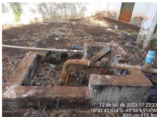
Figura 35. Poços tubulares profundos em operação na área urbana de Ipiaçu.
