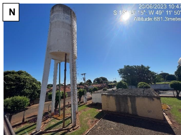
N) Reservatórios R1 (retangular apoiado de 300 m 3 ) e R3 (circular elevado de 100 m 3 )
