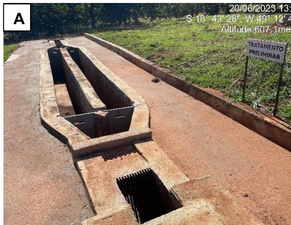
A) Tratamento preliminar (gradeamento e caixas de área)
