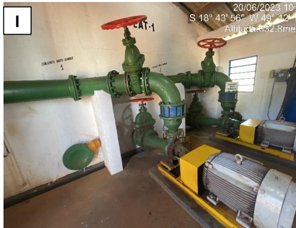
I) Estação elevatória de água tratada (EEAT-1)
