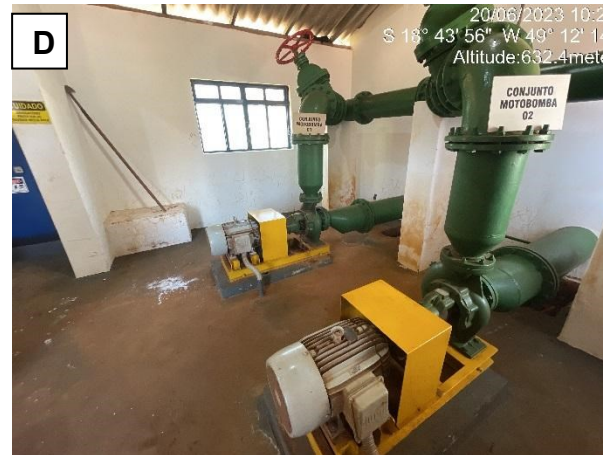
D) Estação elevatória de água bruta (EEAB)
