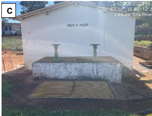
C) Poço de sucção de água bruta
