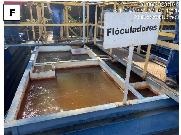
F) Flóculadores com entradas e saídas alternadas
