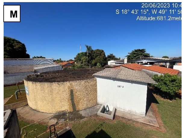
M) Reservatório R2 de 500 m 3 e estação elevatória de água tratada (EEAT-2)
