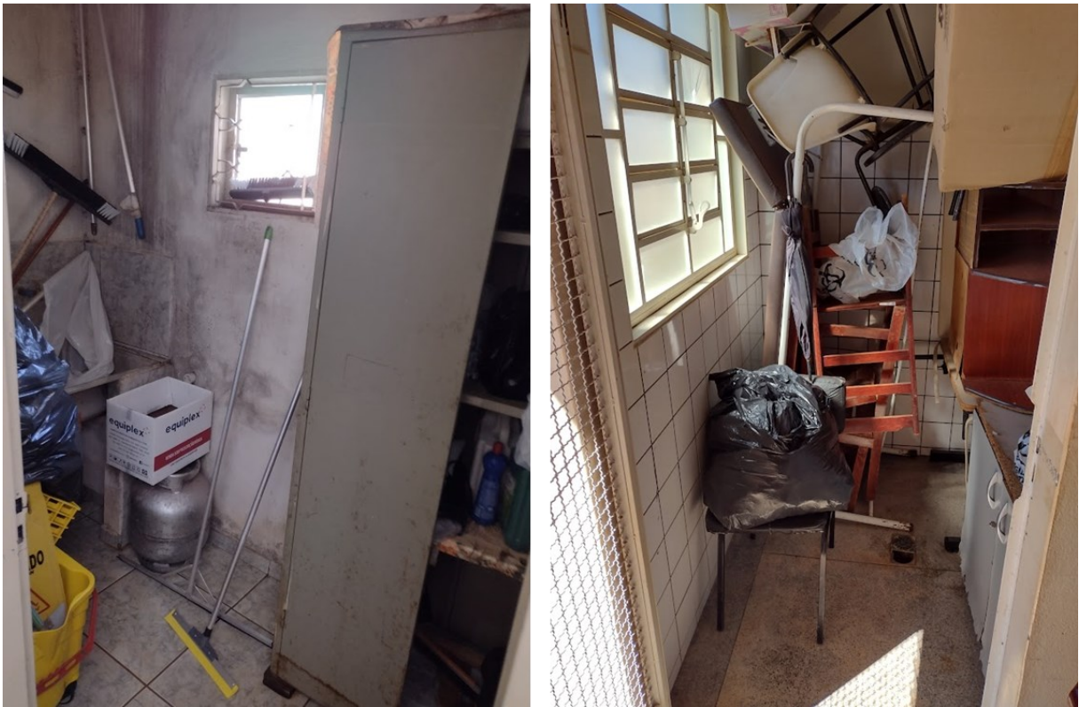
Figura 53. Uso inadequado de armazenamento temporário em estabelecimentos de saúde públicos no município de Canápolis (MG)
