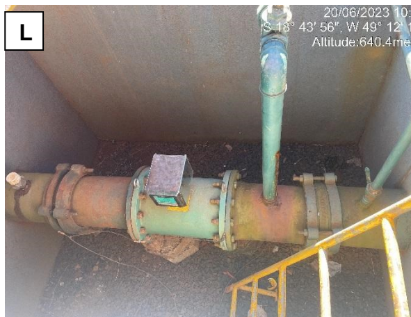
L) Macromedidor no início da adutora de água tratada
