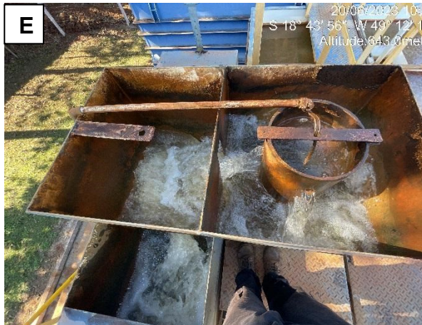
E) Extremidade final da adutora de água bruta e dispositivo de mistura rápida
