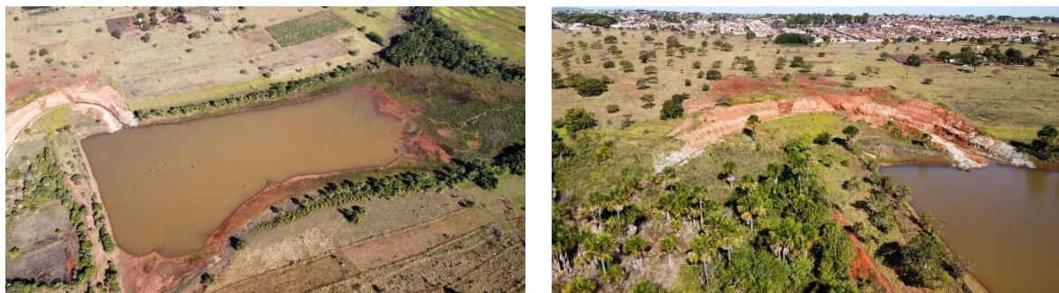
Figura 96 - . Reservatório do Bicano em julho de 2023. Fonte: P.M de Campina Verde
