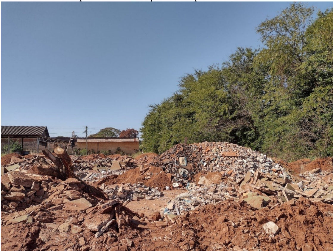
Figura 79 - Área localizada em perímetro urbano de Campina Verde (MG) para destinação de resíduos de construção civil utilizados para nivelção de estradas rurais
