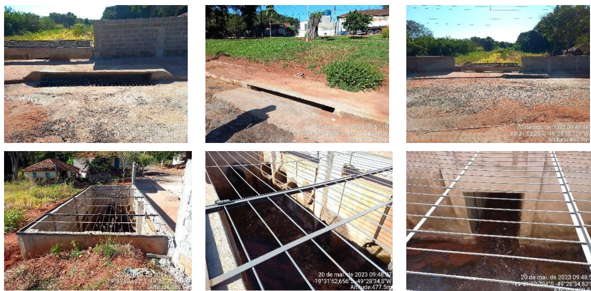
Figura 94 - Caixa de passagem e bocas-de-lobo na região baixa do setor 2. Fonte: Autores (2023)
