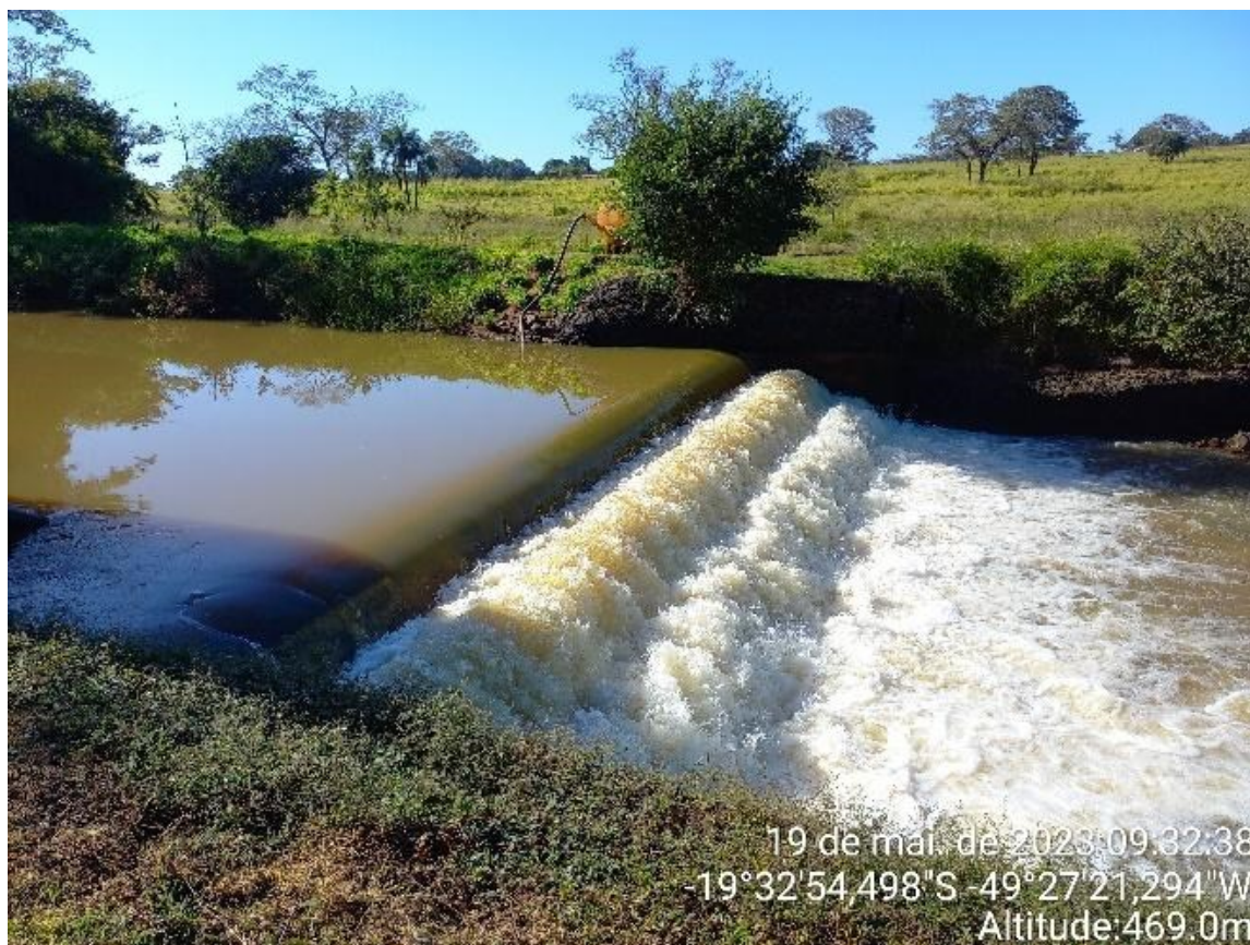
Figura 22 - Barragem de nível no rio Verde.
