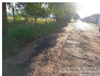
Figura 89 - Destaque das regiões com processo erosivo e acúmulo de resíduos nas sarjetas
