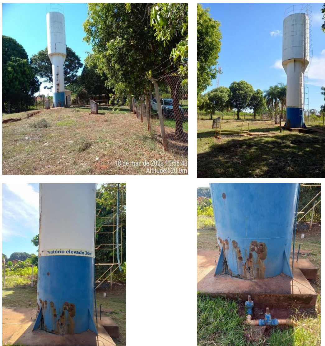
Figura 38 - Reservatório elevado REL existente no distrito de Honorópolis
