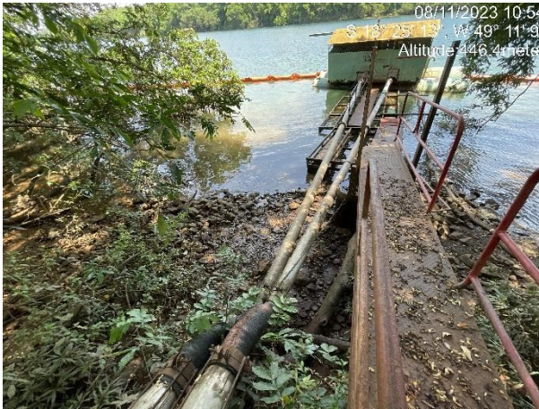
(c) Início do traçado das linhas adutoras do sistema de captação flutuante
