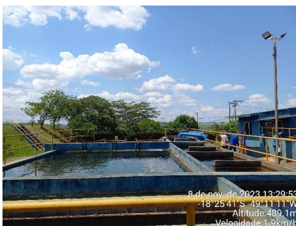
(a) Entrada da adutora do Sistema Furnas-Araporã no tanque de mistura rápida
