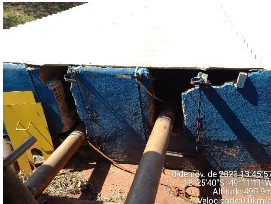
(c) Vulnerabilidade à contaminação no tanque de contato retangular
