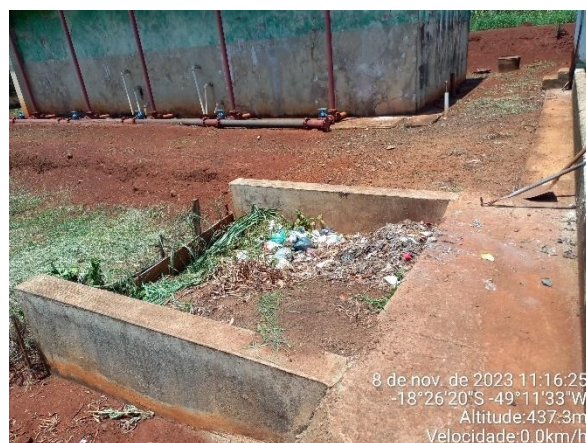
(d) Local para depósito de material gradeado
