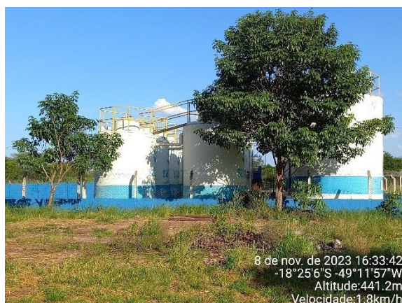
(a) Vista lateral dos reatores, na sequência das etapas de tratamento (RAFA, coluna de aeração e decantação secundário)
