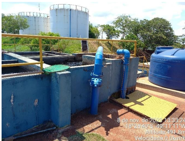
(a) Entrada da adutora do Sistema Furnas-Araporã no tanque de mistura rápida
