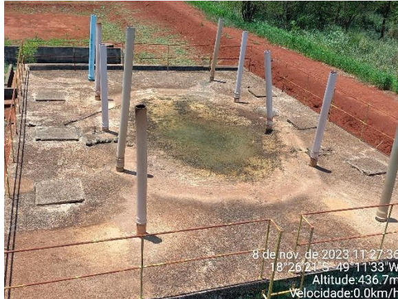
(k) Vista superior do filtro anaeróbio
