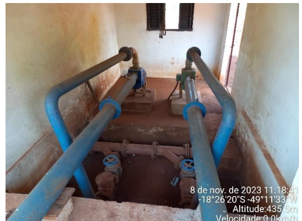
(g) Detalhe dos dois conjuntos motobombas em paralelo
