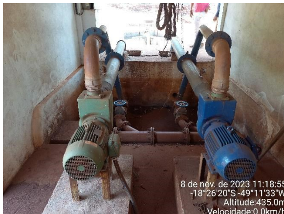
(g) Detalhe dos dois conjuntos motobombas em paralelo
