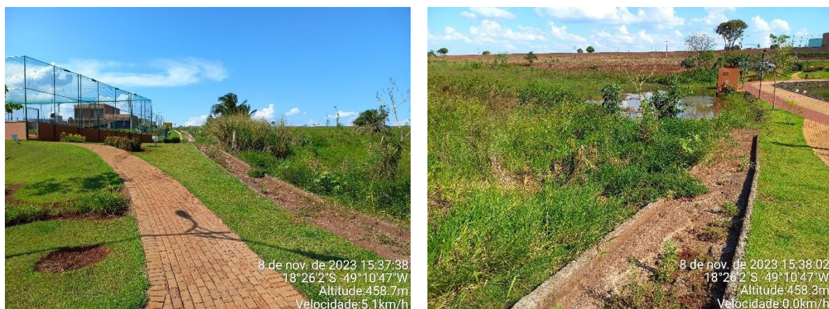
(b) Exutório superficial no córrego Alvorada (margem direita)
